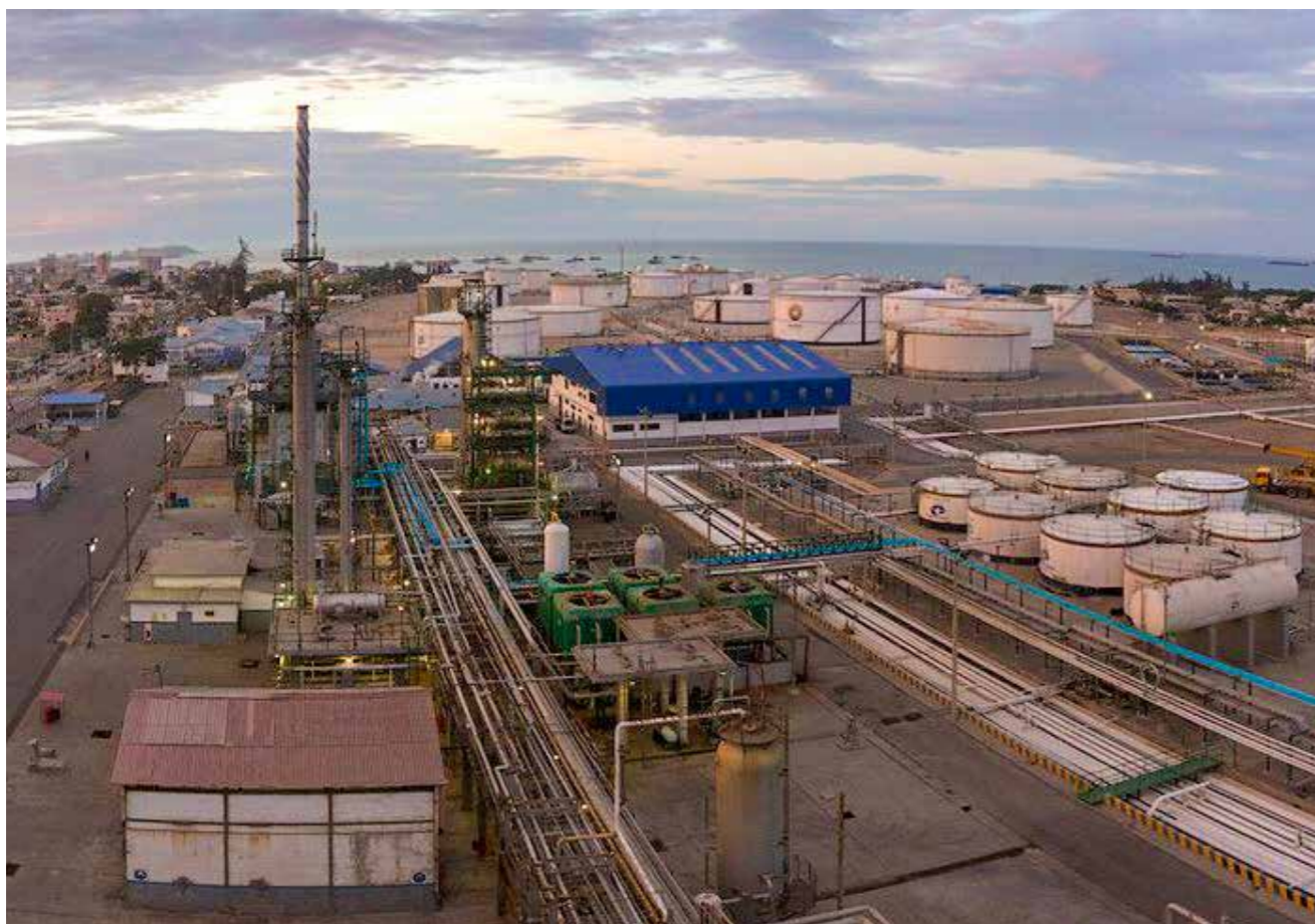
Refinería Libertad - Tomado de la cuenta oficial de Petroecuador en Flickr
